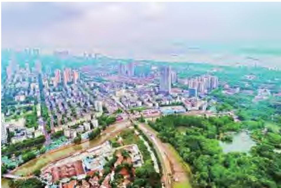
武九铁路穿过青山，将建设十路横向切断。
